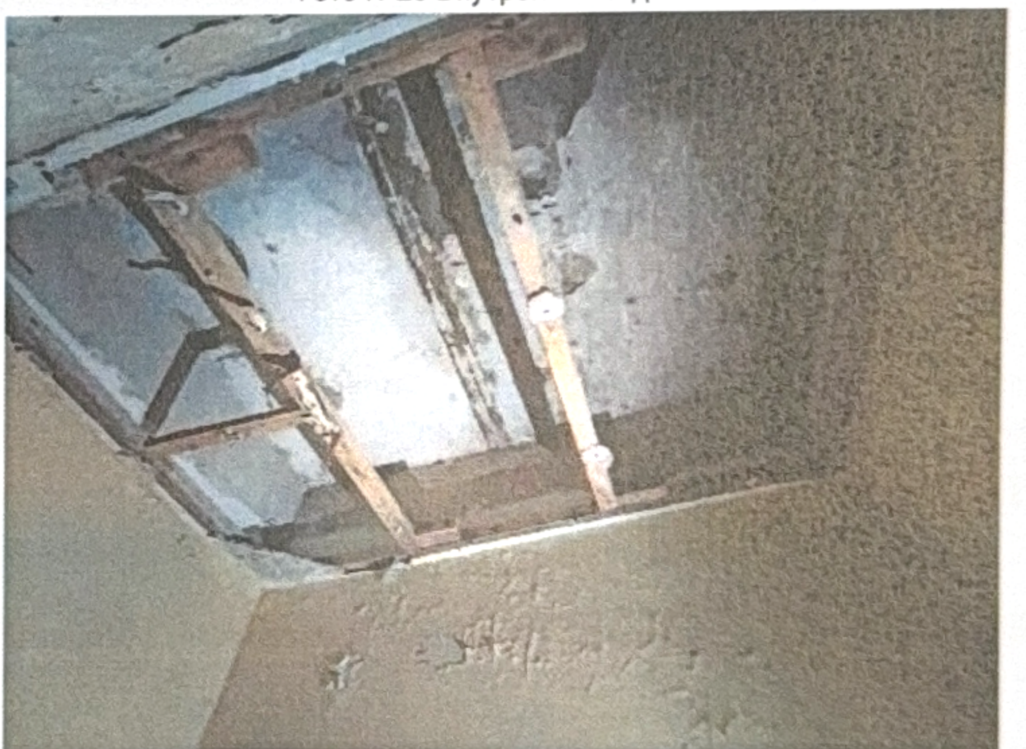
Фото №28 Внутренняя отделка
