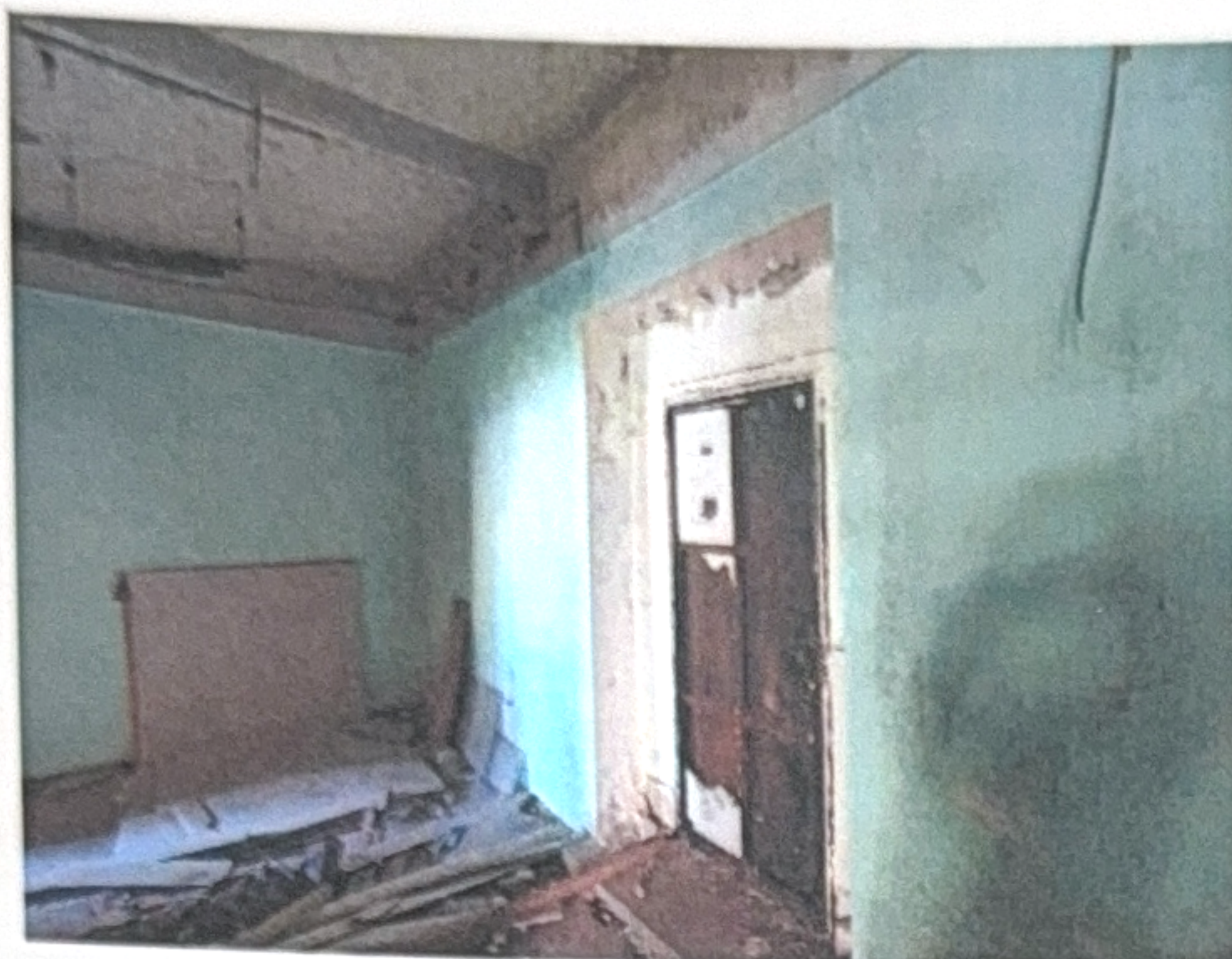
Фото №15 Внутренняя отделка
