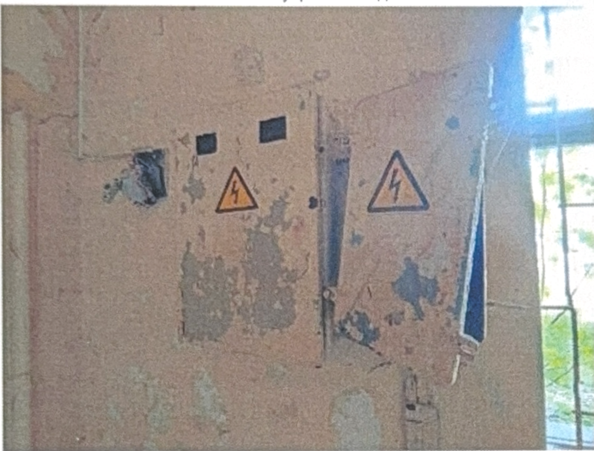
Фото №25 Внутренняя отделка
