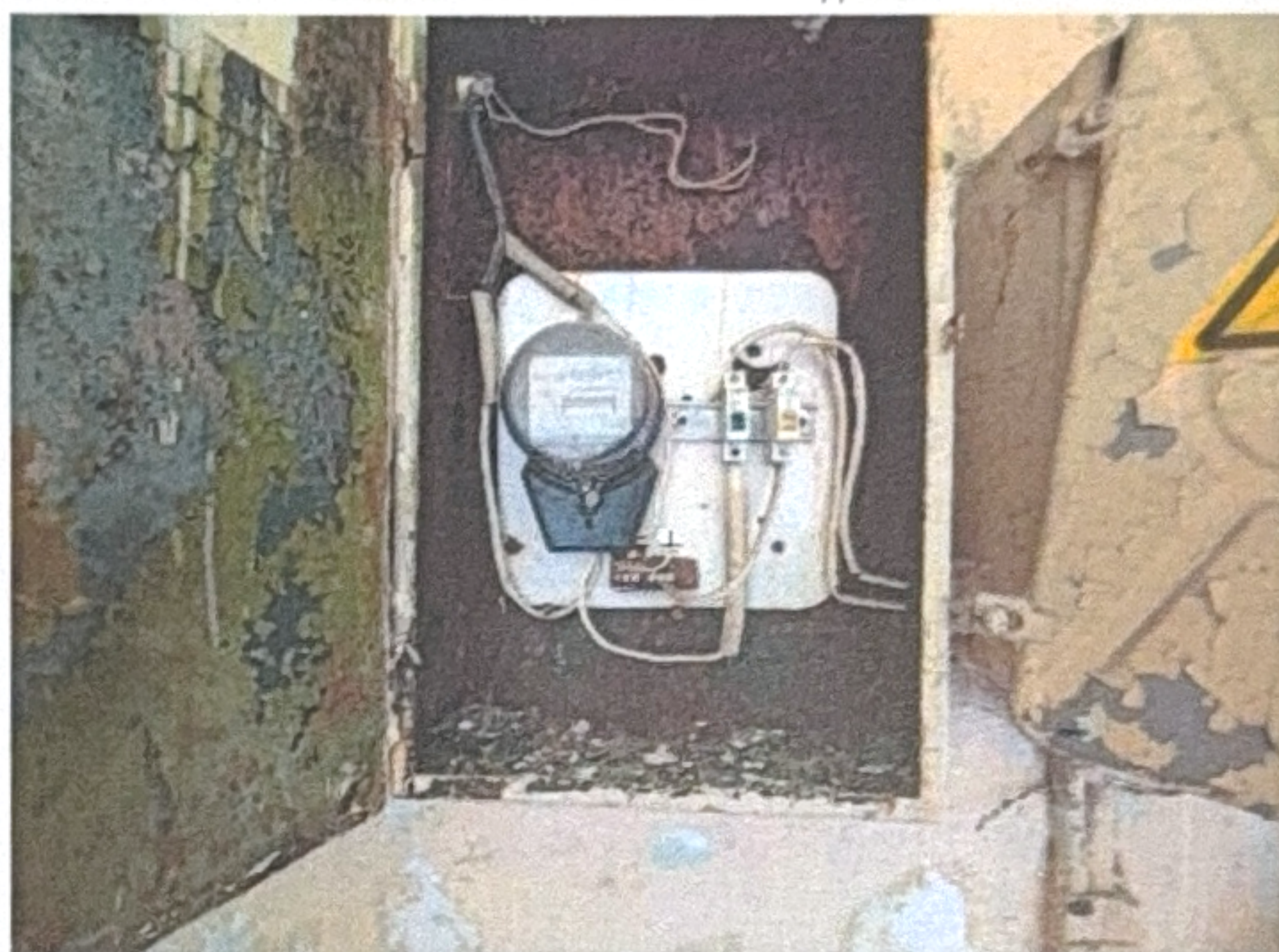
Фото №10 Внутренняя отделка
