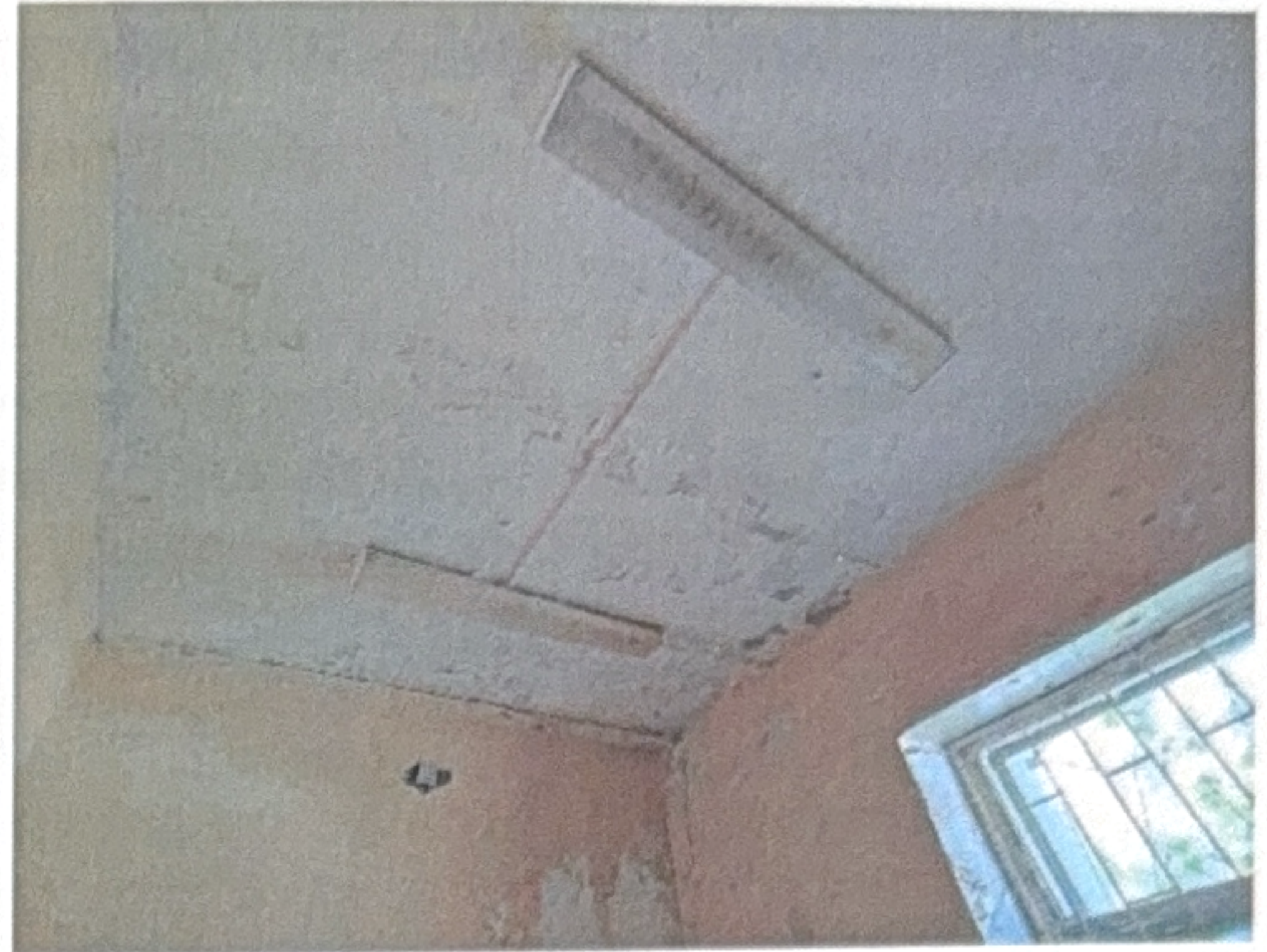
Фото №24 Внутренняя отделка
