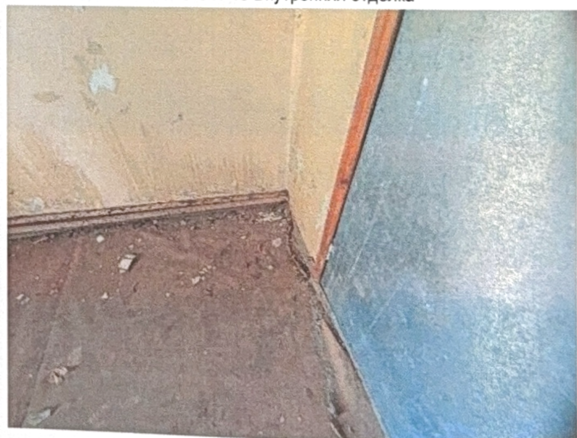
Фото №20 Внутренняя отделка
