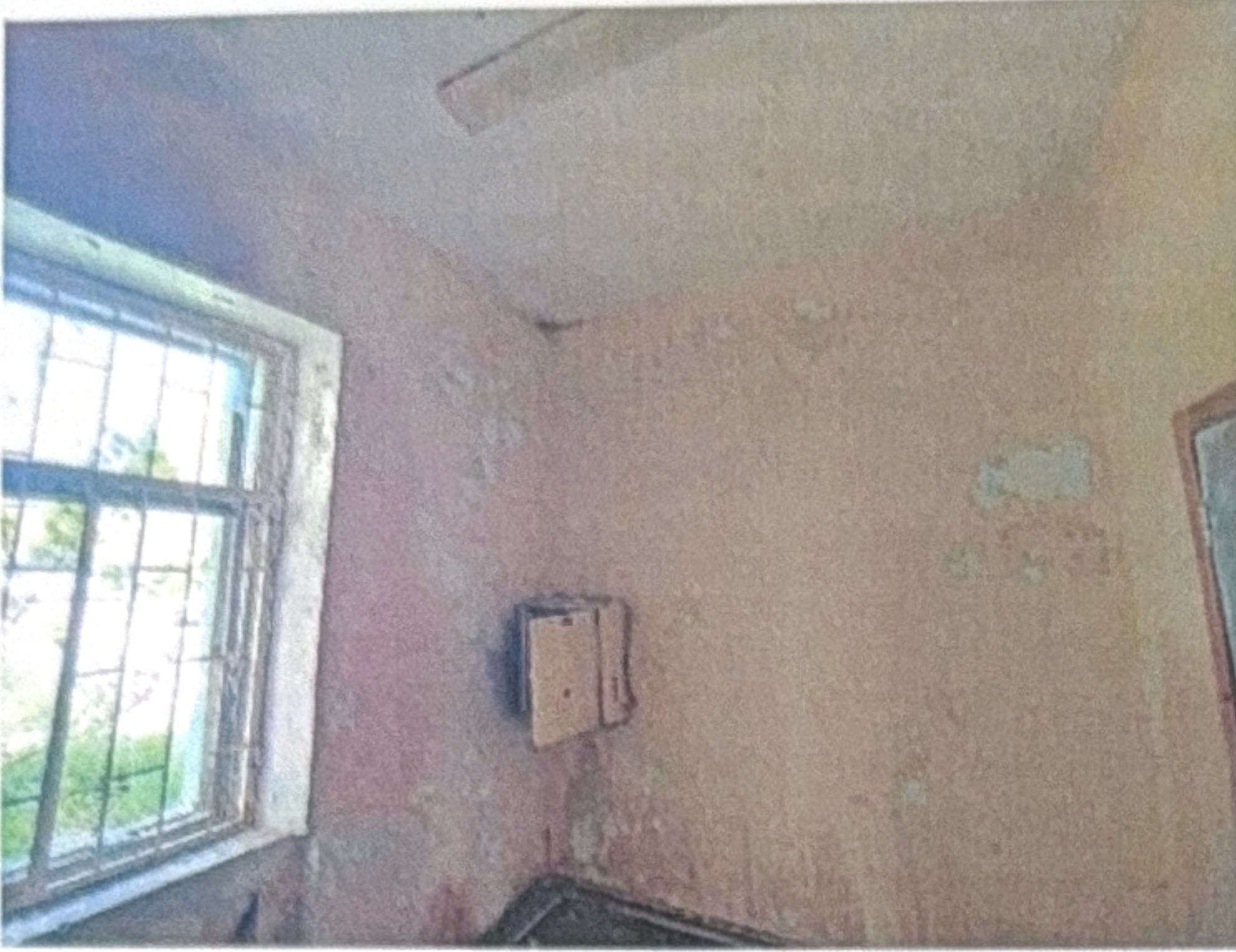
Фото №23 Внутренняя отделка
