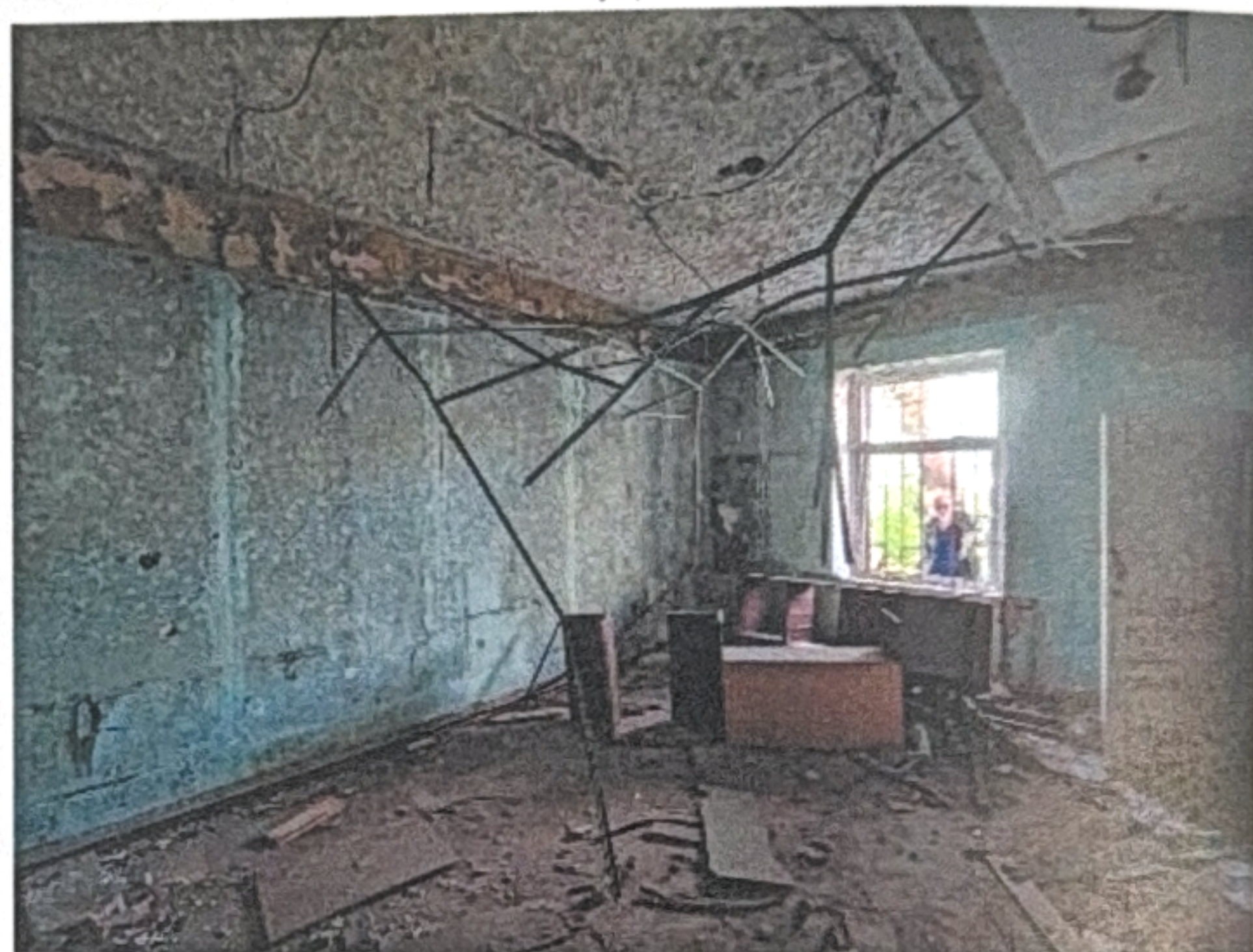
Фото №18 Внутренняя отделка
