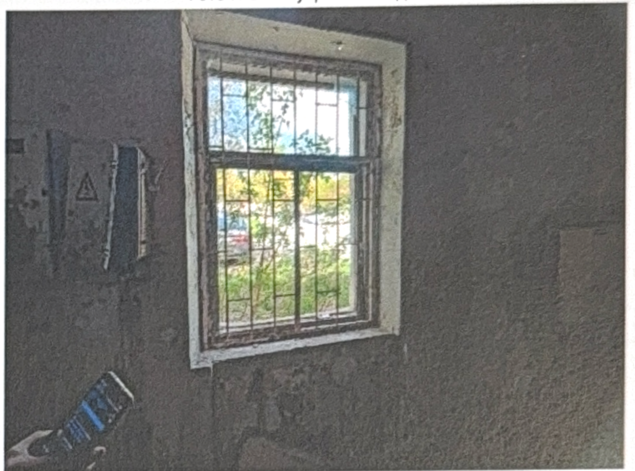
Фото №26 Внутренняя отделка
