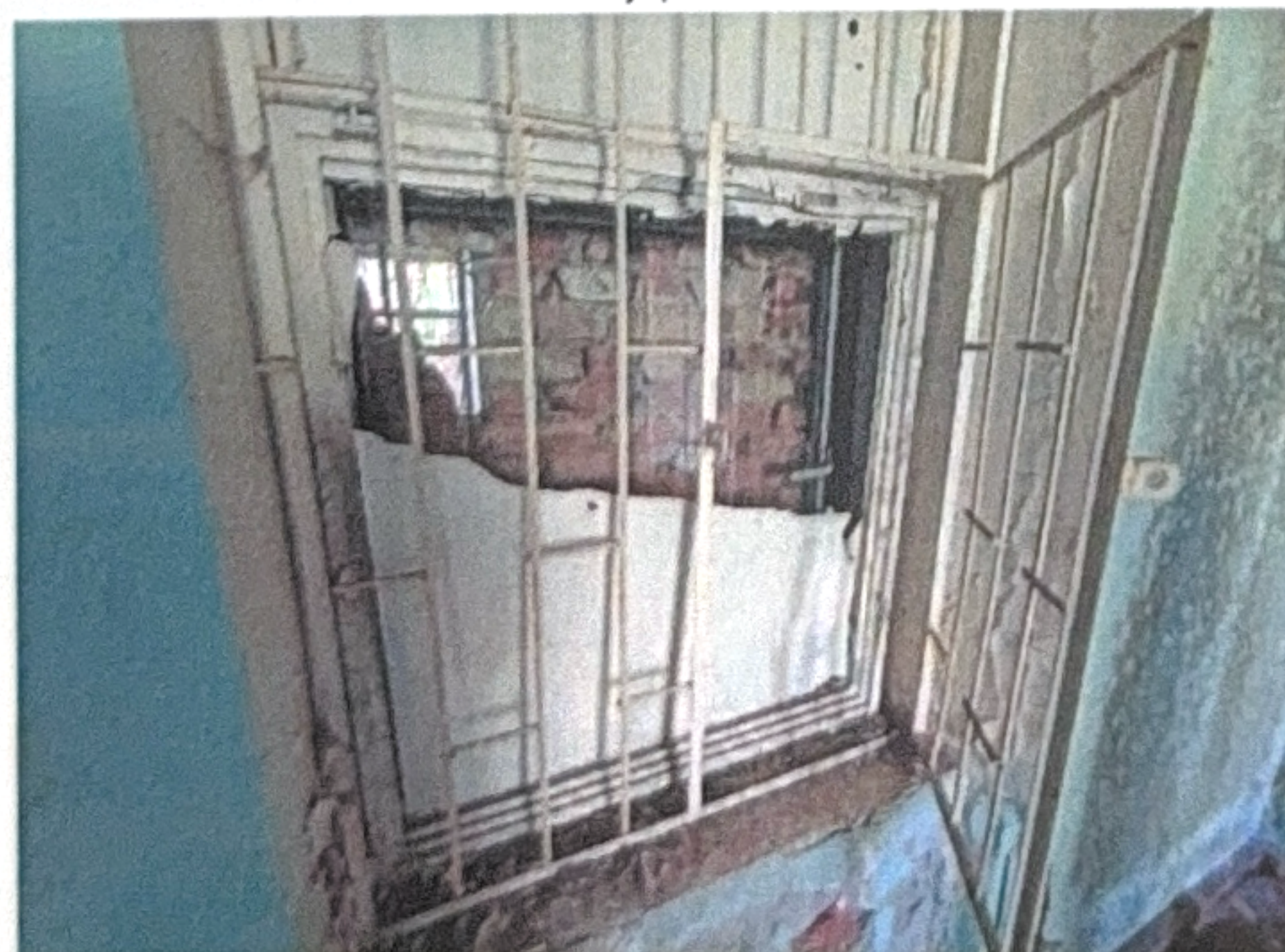
Фото №13 Внутренняя отделка
