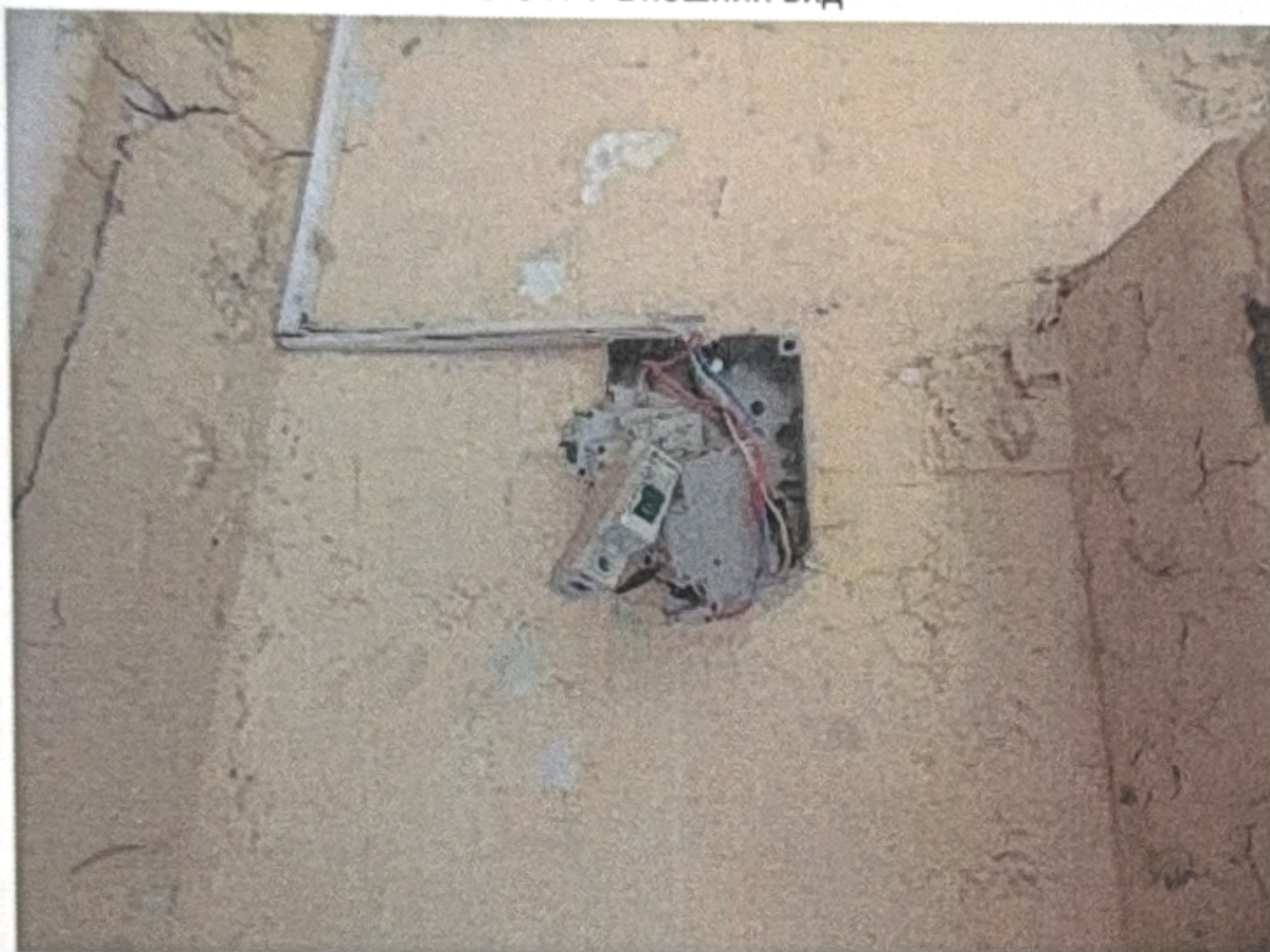
Фото №9 Внутренняя отделка
