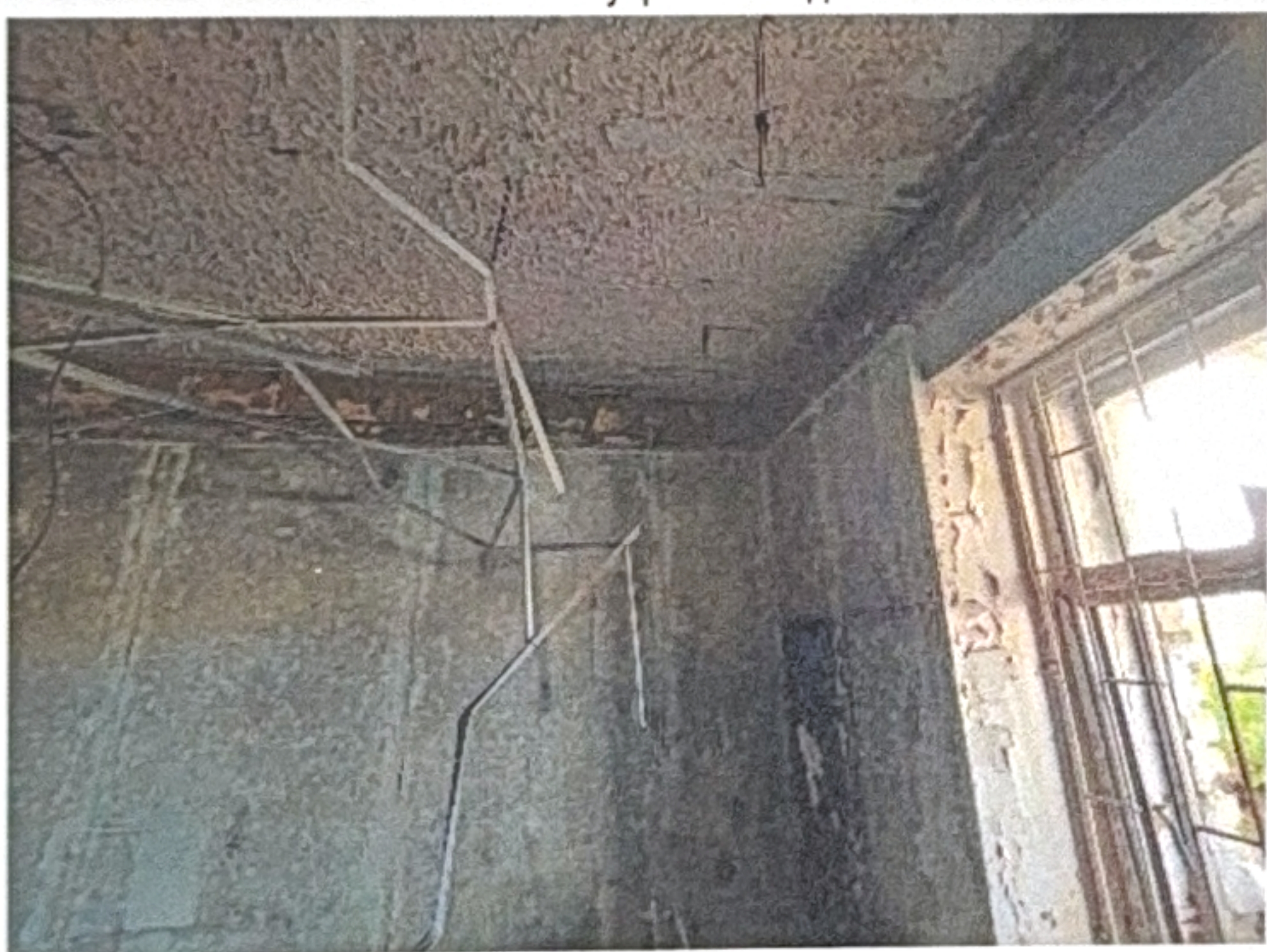
Фото №27 Внутренняя отделка
