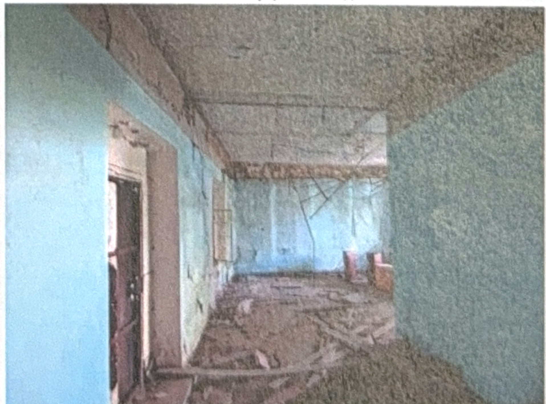
Фото №14 Внутренняя отделка
