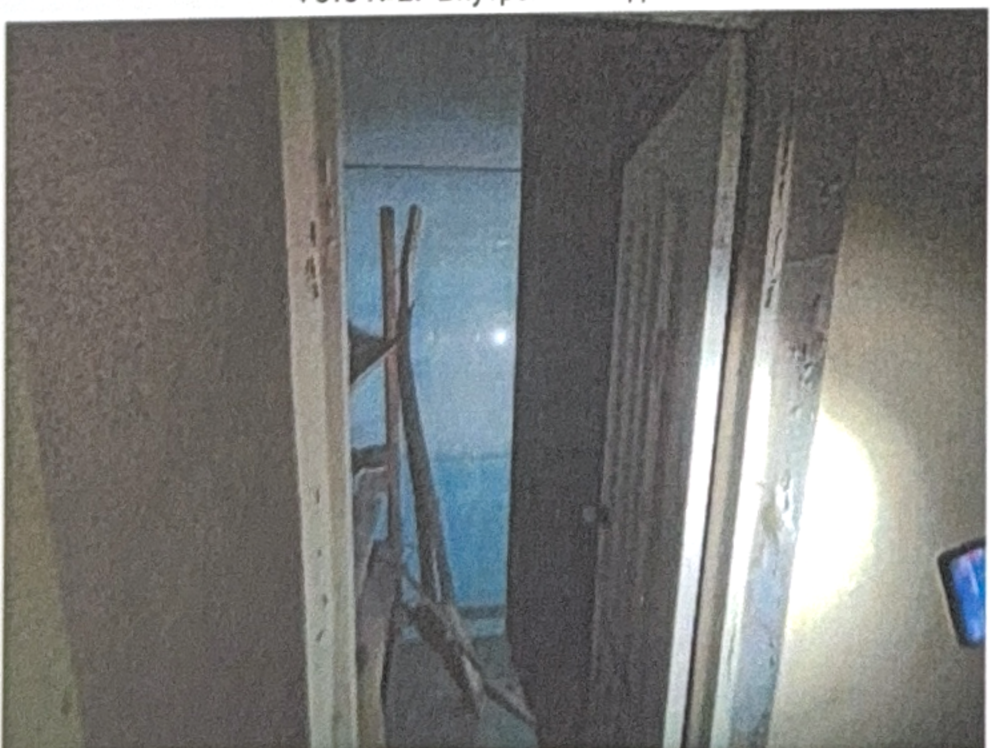
Фото №29 Внутренняя отделка
