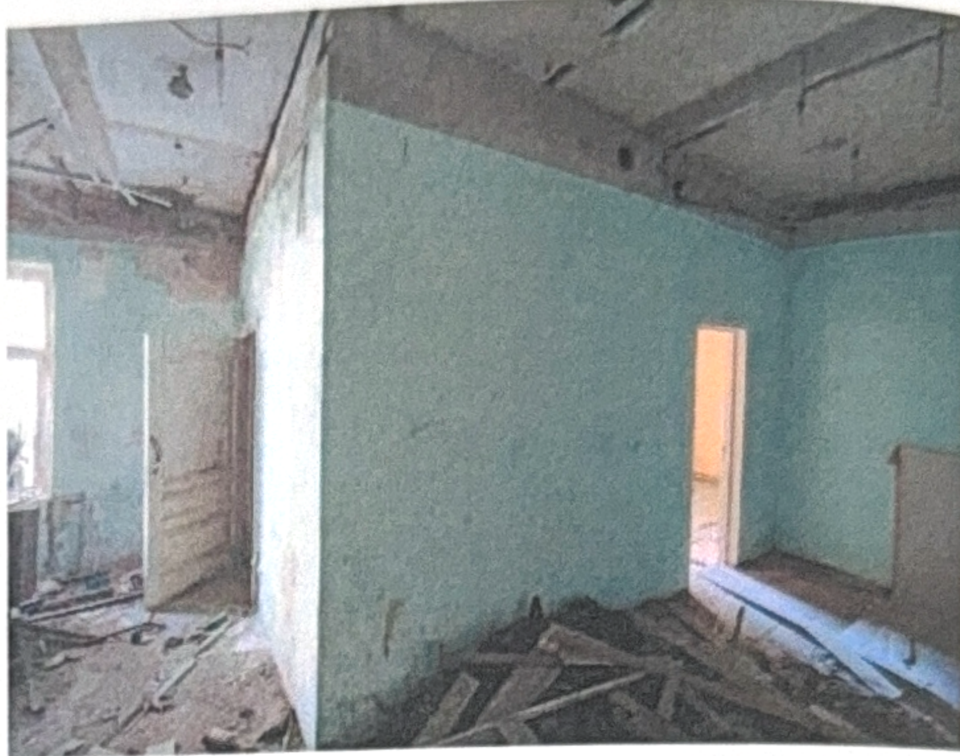
Фото №16 Внутренняя отделка
