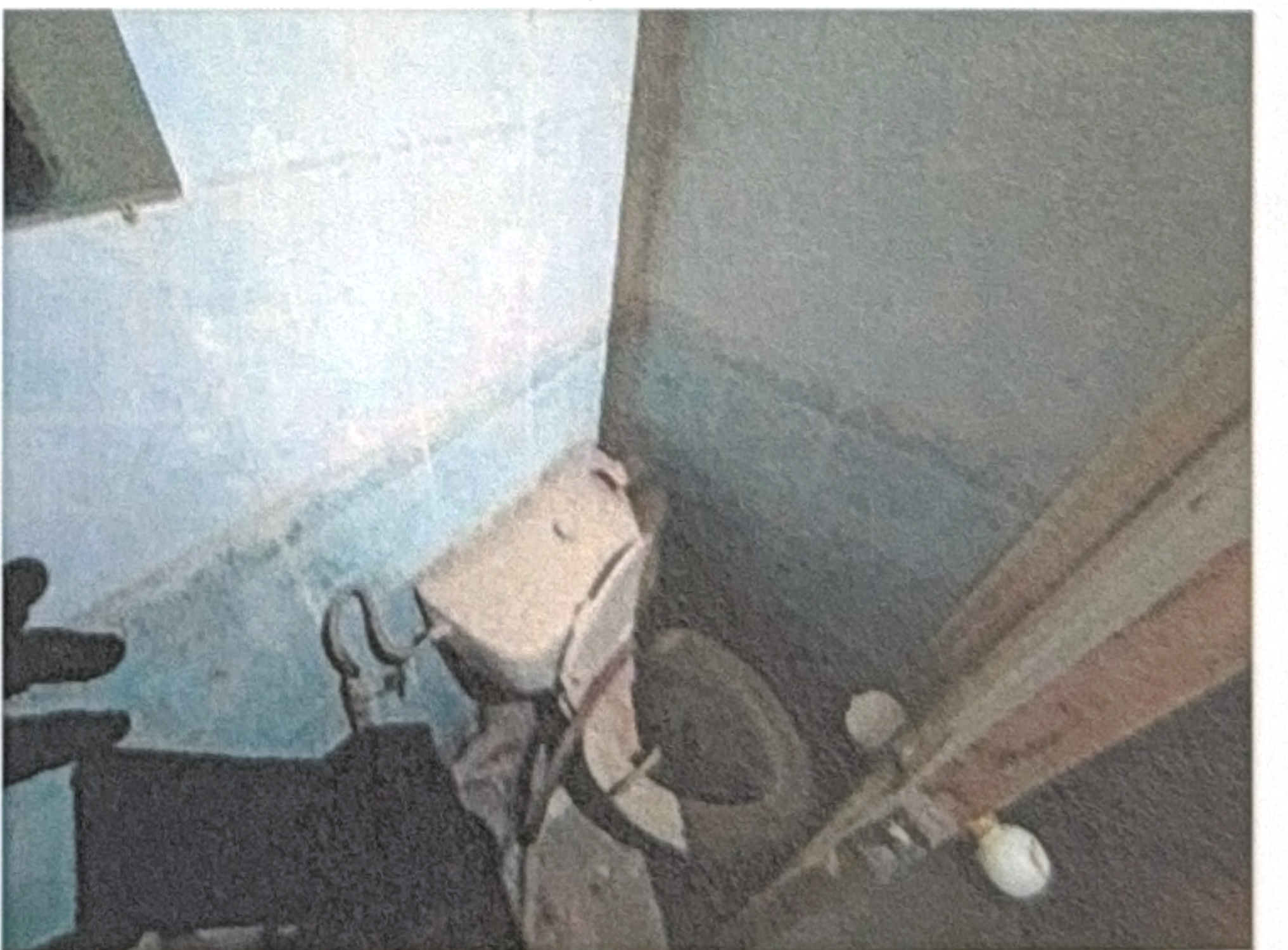
Фото №30 Внутренняя отделка
