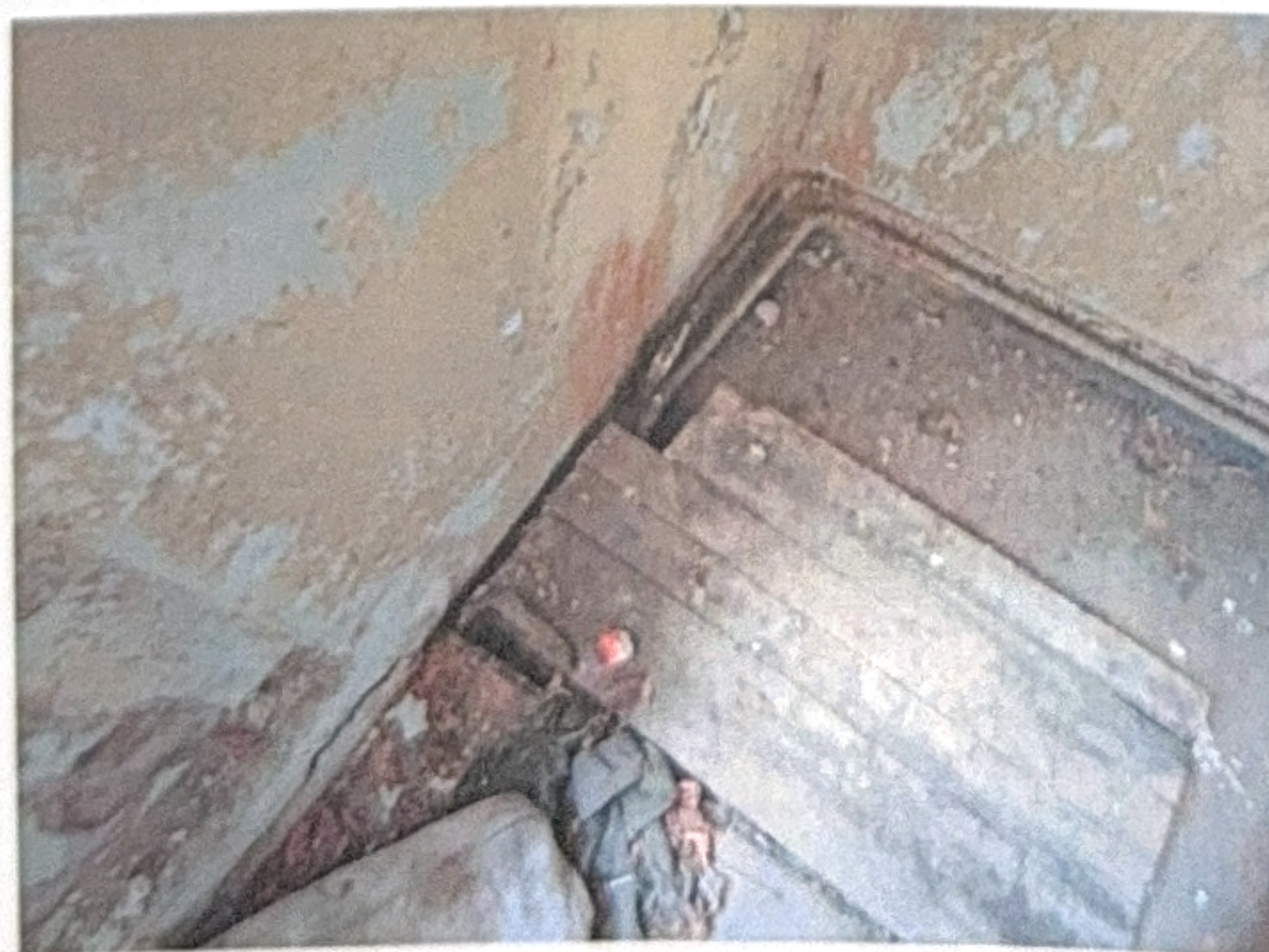
Фото №21 Внутренняя отделка
