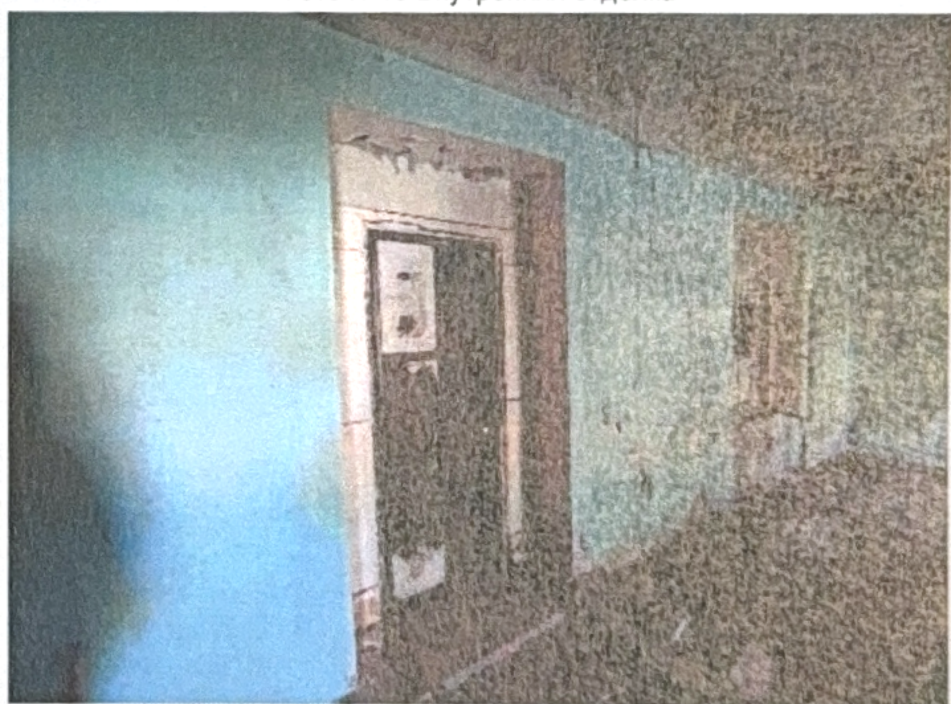
Фото №12 Внутренняя отделка
