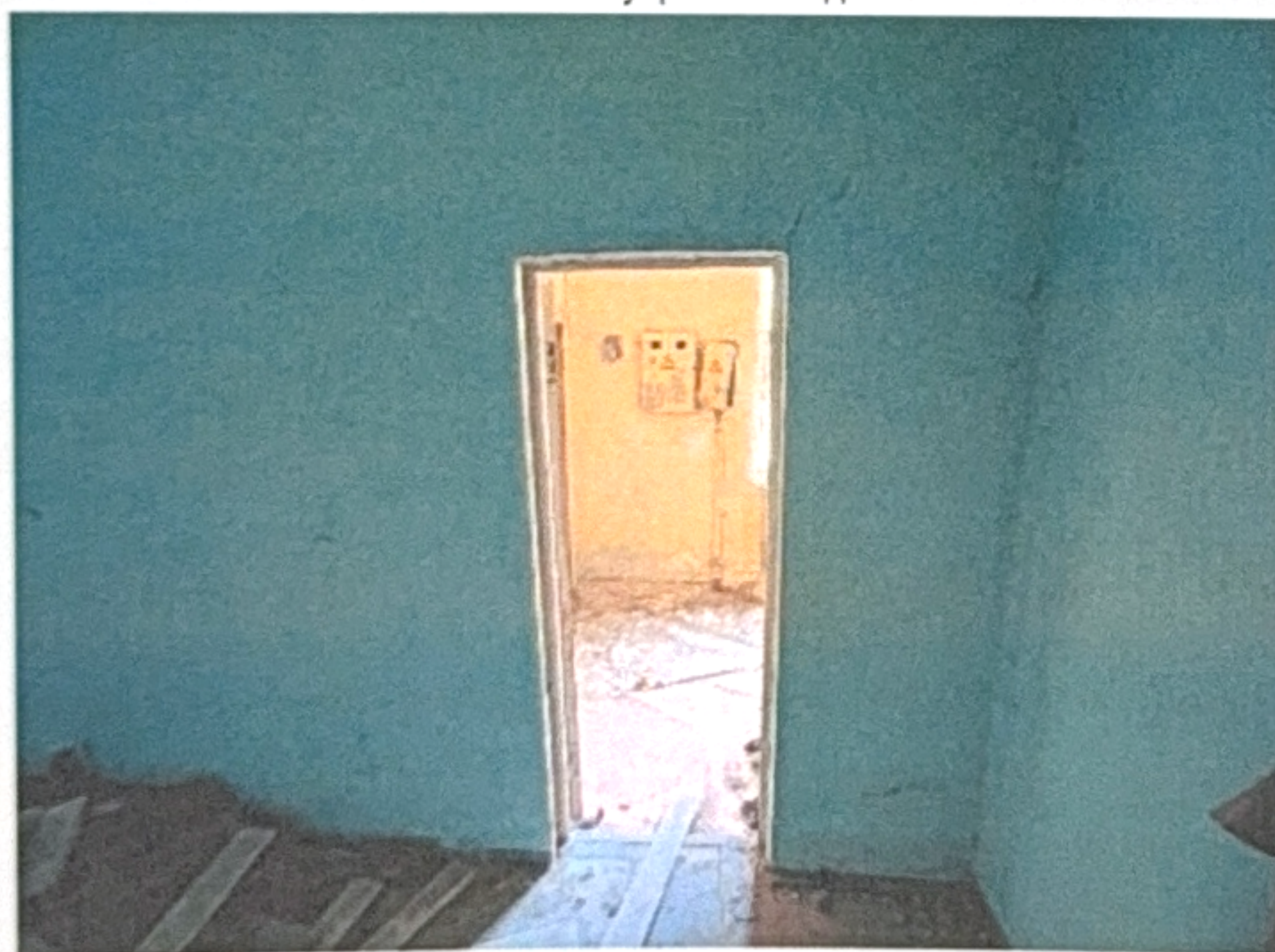
Фото №19 Внутренняя отделка
